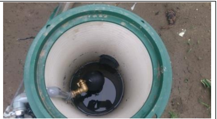
安裝水位控制閥
